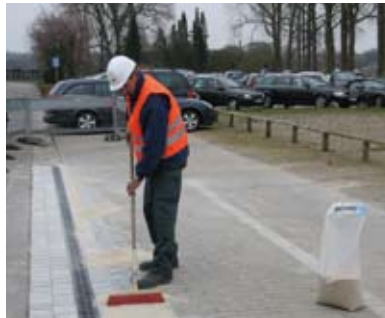
8. Wypełnianie szczelin piaskiem kwarcowym.
