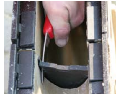
6. Dopasowanie prefabrykowanej ścianki z gumy do wysokości zabudowywanego kanału.
