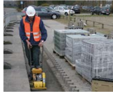
3. Położenie fundamentu i jego zagęszczenie.
