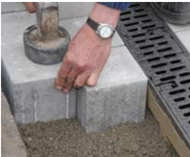
7. Bezpośrednie obrukowanie ciągu kanałów.
