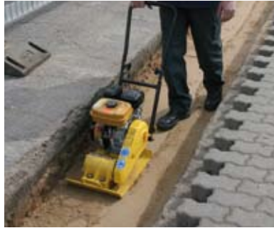
2. Nałożenie warstwy wyrównawczej i jej zagęszczenie.
